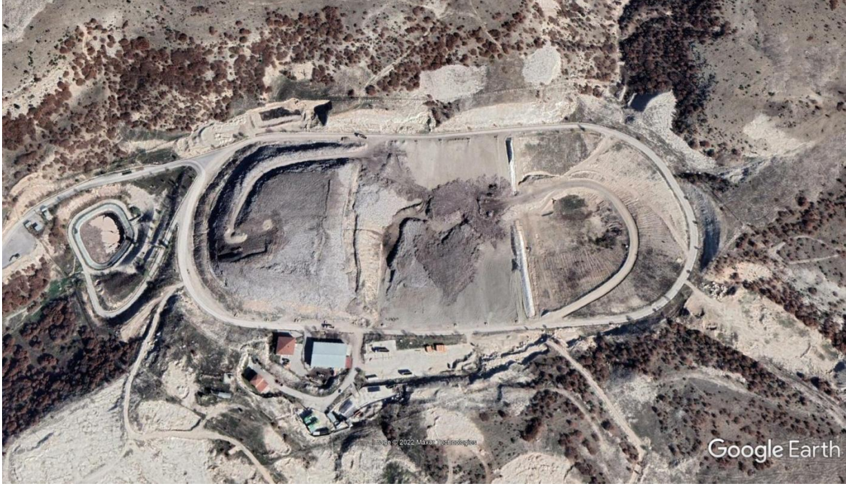
Resim 2. II. Sınıf Düzenli Depolama Sahası Genel Görünümü
