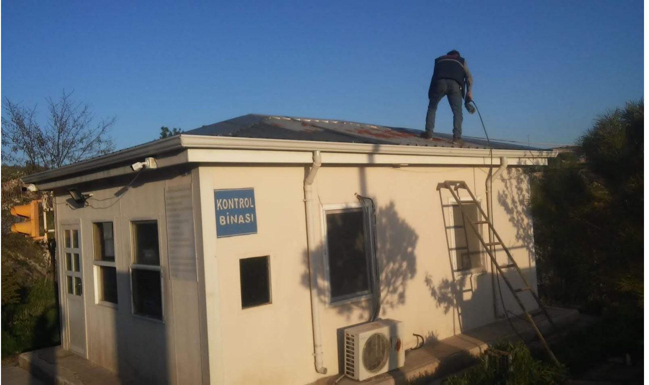
Resim 8. Düzenli Depolama Sahası Kontrol Binası
